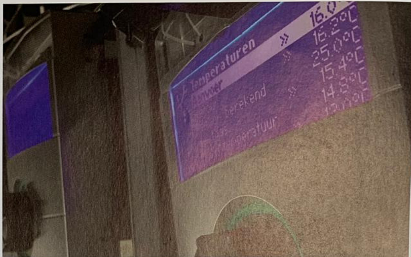
△ De Luxtronik-regelaar die verbonden is aan de warmtepomp.
