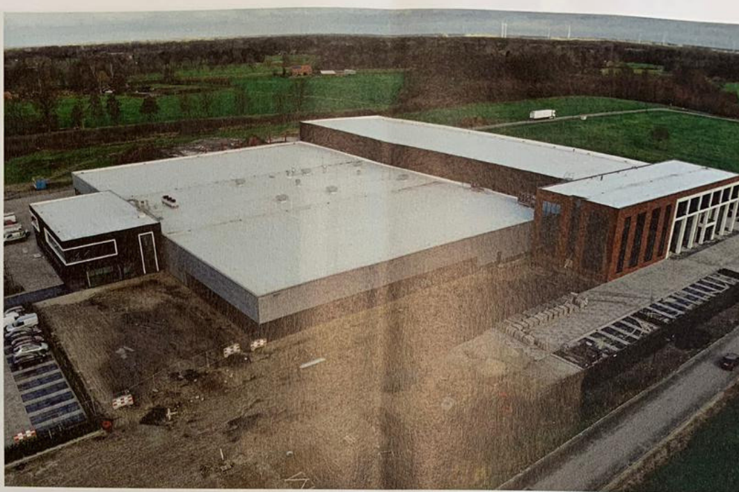
△ Witte dakbedekking houdt de warmte in de zomer buiten.
